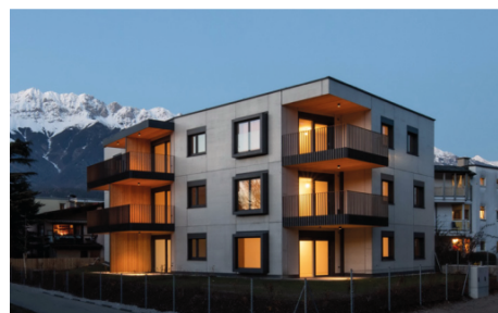
Montáž a hotová budova
